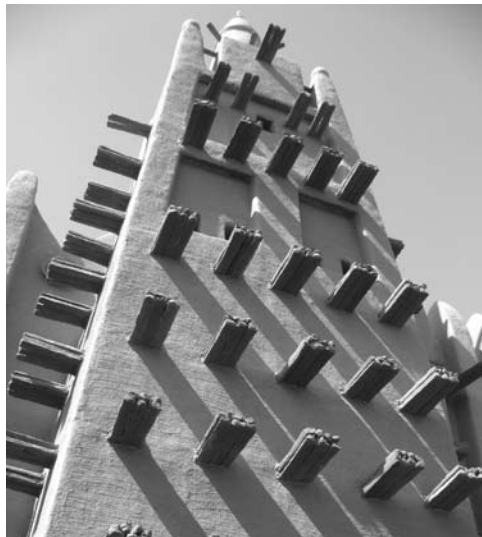
Figura 5: Restauración de la mezquita de Mopti, Mali.
