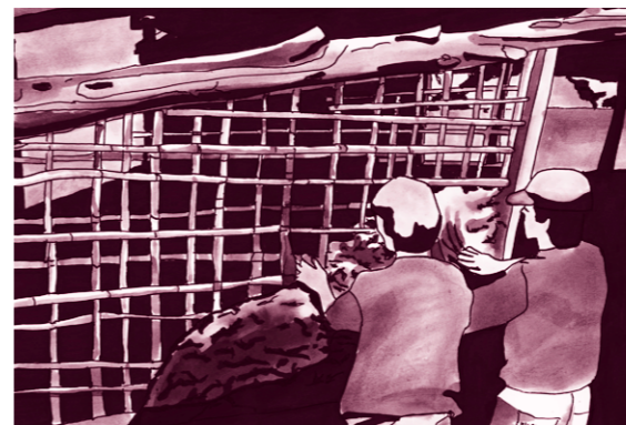
Enchimento, terra de recobrimento (tabiques em terra).
