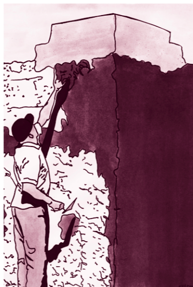
Rebocos em terra.
