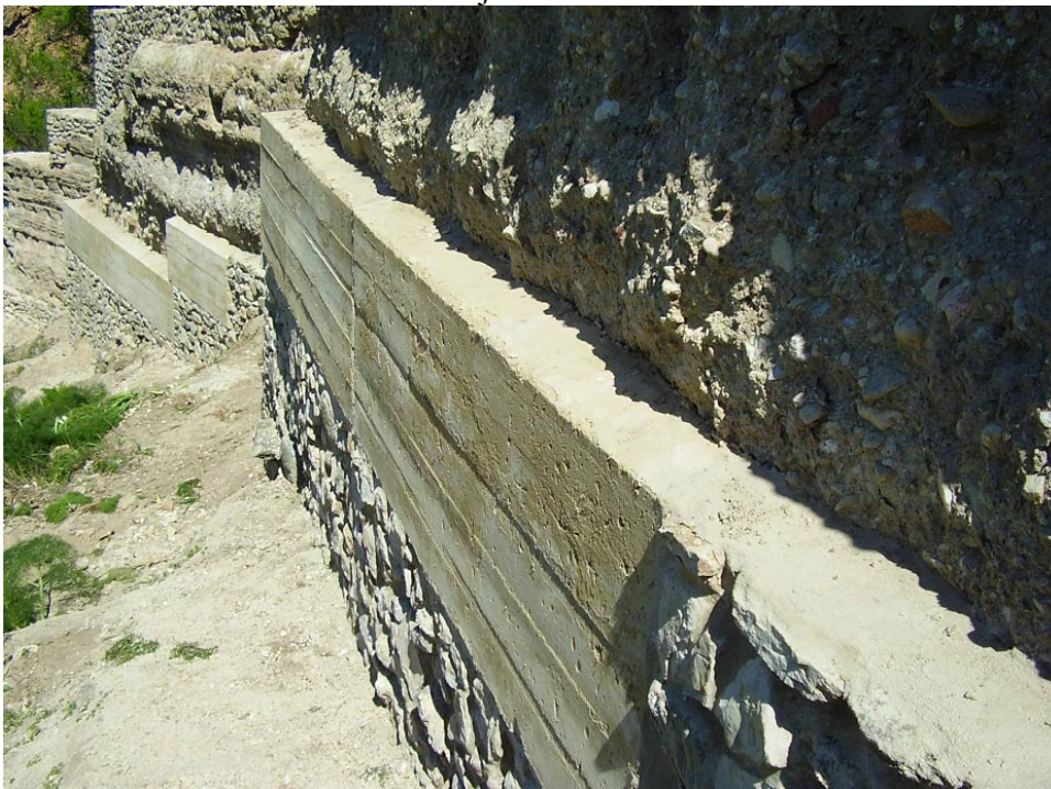
Lám. 11. Detalle de los nuevos cajones añadidos a la muralla del Albacar de Ronda.
