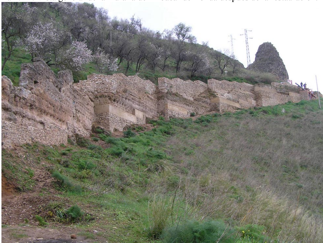
Lám. 12. Vista general de la muralla del Albacar de Ronda después de la restauración.
