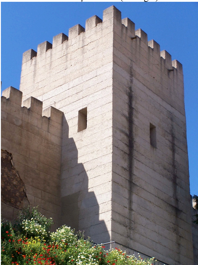
Lám. 7. Vista general de una torre restaurada con proyectados de hormigón en la fortificación de Alcácer do Sal (Portugal).
