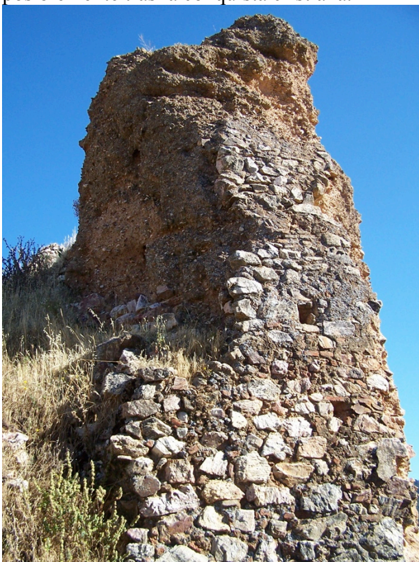
Lám. 2. Estructuras de tabiya en el castillo de Hornachos forradas con mampostería posiblemente tras la conquista cristiana.
