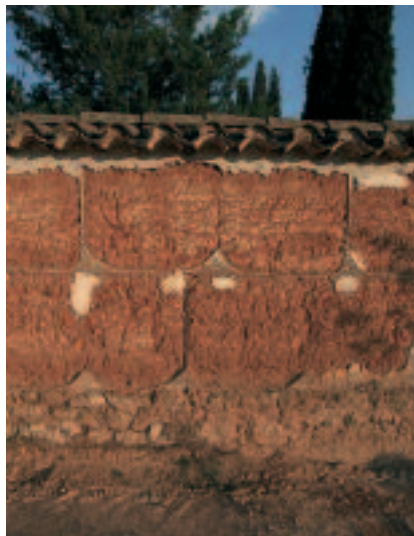
Figura 1. Muro di terra rinforzato con gesso. Cimitero di Torrebaja, Valencia, paramento occidentale (foto degli autori).
