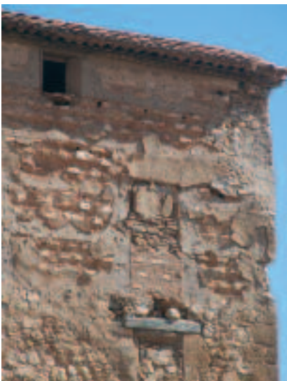
Figura 5. Fenomeno di perdita della superficie del paramento occidentale della Canonica di Castielfabib (Valencia), per mancata manutenzione ed esposizione agli agenti atmosferici (foto degli autori).
