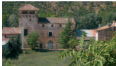
Figura 3. Muro di terra rinforzato con gesso. Cimitero di Torre3. Casa-torre di Torrealta (Valencia), i cui muri sono realizzate con calcestruzzo di calce e pietre con rinforzi ondulati di gesso, nella casa e con calcestruzzo di calce e mattoni nella torre (foto degli autori).
