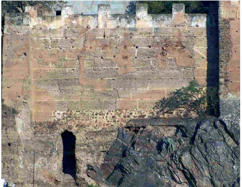
Fig. 3. Lienzo oriental del bastión de la Torre de los Pozos (Cáceres). Obsérvese el encintado del muro y enjalbegado de pretil y merlones
