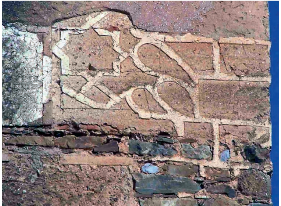
Fig. 5. Una de las dos estrellas de ocho puntas conservadas en la faz oriental de la albarrana de los Pozos (Cáceres)
