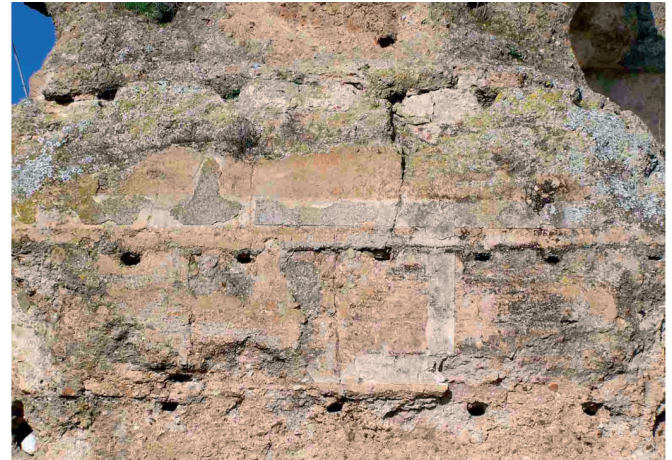
Fig. 2. Torre de la fortificación de El Vacar donde se aprecia la no coincidencia entre las líneas de mechinales y las cintas de mortero de cal
