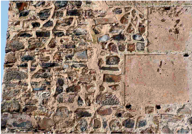
Fig. 1. Zona inferior de la Torre de los Pozos, en el recinto almohade de Cáceres, en la que destaca el acabado superficial con un encintado calizo que bordea los mampuestos esquineros y marca las hiladas de tapia
