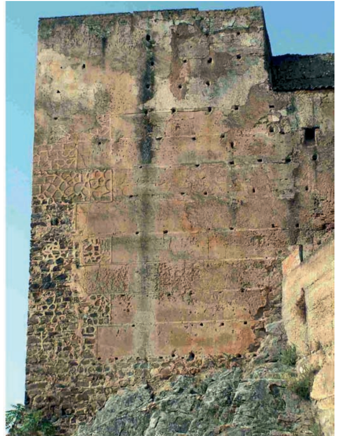
Fig. 4. Cara norte de la albarrana de los Pozos (Cáceres)
