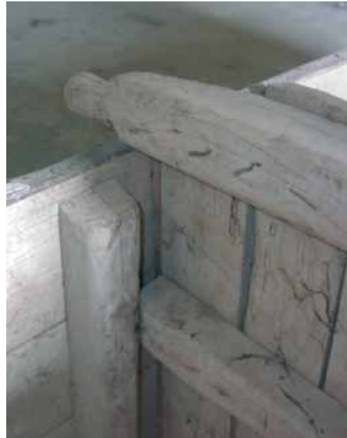
16.1 Detalle de frontera (Pozocañada).
