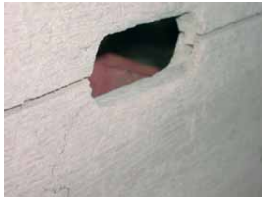
Fig 14. Maneta intermedia (nótese el machihembrado entre las tablas, sin duda este tapial es más moderno que los anteriores)
