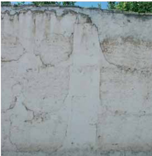
Tapia con breñas y juntas reforzadas
