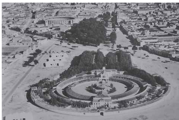
Vista del recinto ferial a mediados del siglo XX, tras la última ampliación de 1944
