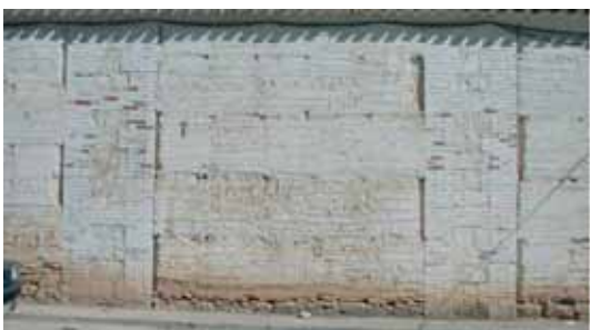
Fábrica mixta de ladrillo y tapia
