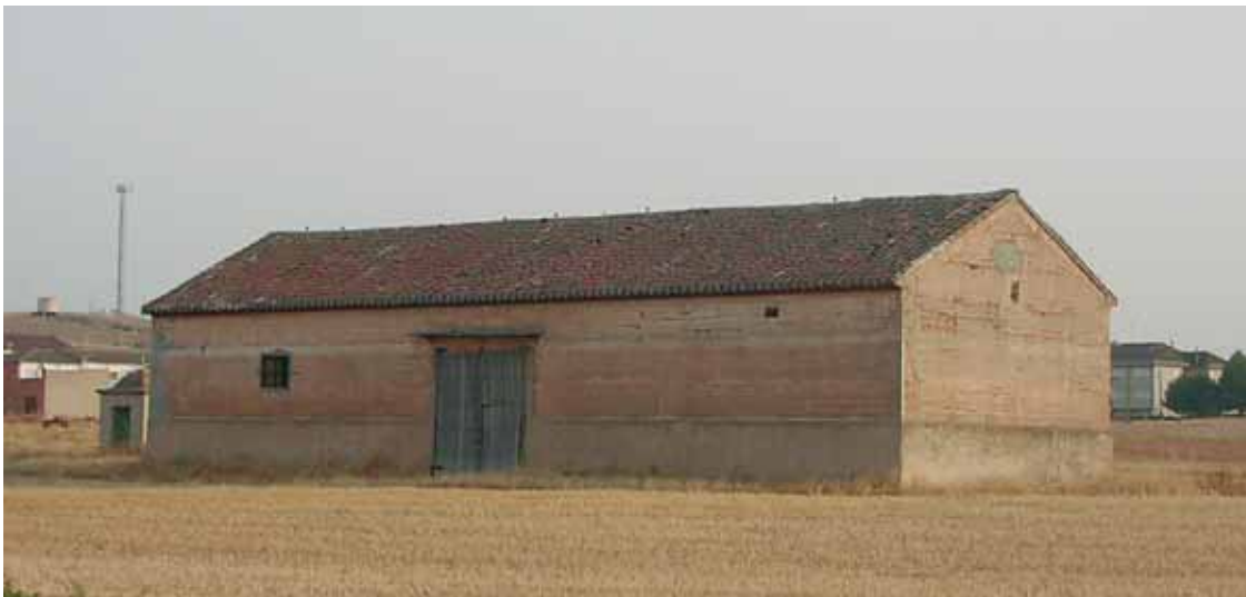
Nave, Pozo Cañada
