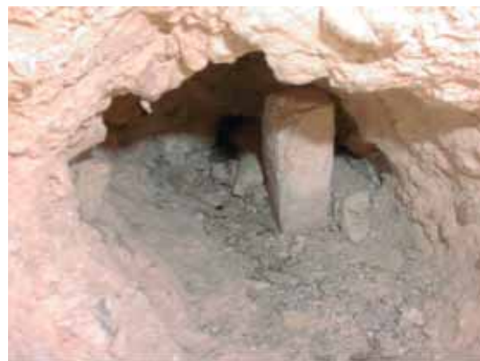
Detalles de medias agujas clavadas en un orificio del muro (Jorquera)
