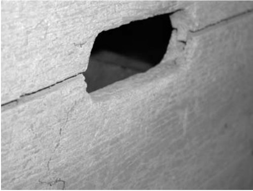
Figura 8 Maneta intermedia (nótese el machihembrado entre las tablas, sin duda este tapial es más moderno que los anteriores)
