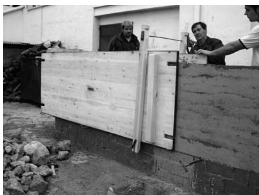
Figuras 17 y 18 Desplazamiento del tapial Escuela Taller Castillo de Almansa (2003)
