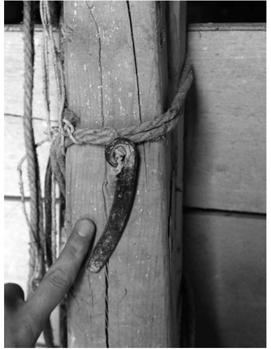
Figuras 12 y 13 Detalle de agujas y clavija
