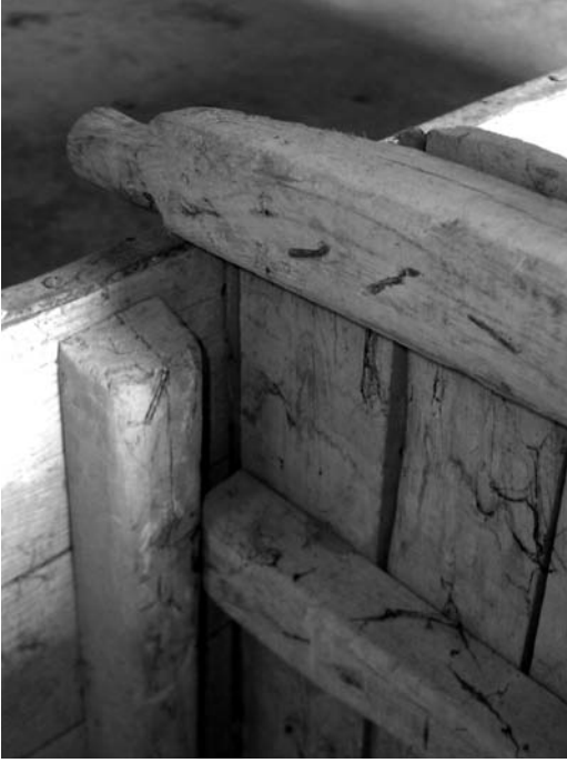
Figura 10 Detalle de frontera (Pozocañada)
