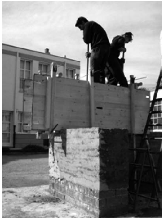
Figura 16 «Pisando» una tapia Escuela Taller Castillo de Almansa (2003)
