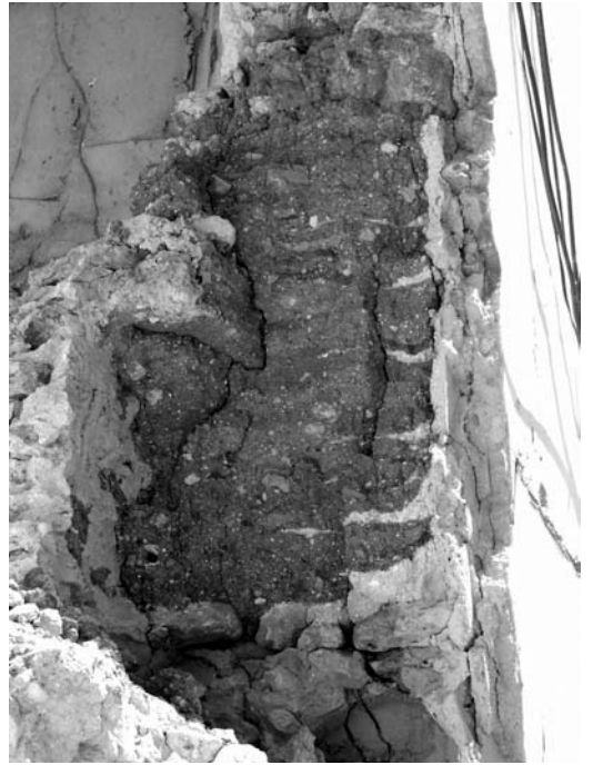
Figura 20 Sección de tapia con costra sobre la que se ha aplicado un revoco posteriormente (derecha, Villarrobledo)
