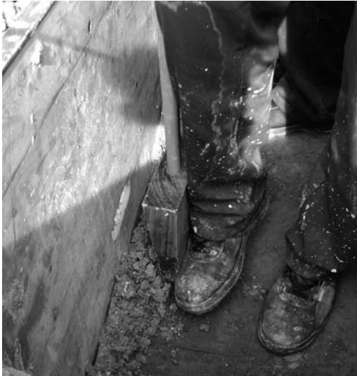
Figura 19 Detalle de ejecución de costra durante la construcción de una tapia (izquierda, escuela taller de Almansa)
