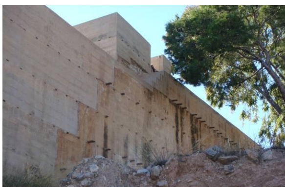
Figura 4. Lienzo de la muralla exterior del castillo de la Mola (Novelda) con los volúmenes regularizados. Fuente: F. Vegas & C. Mileto
