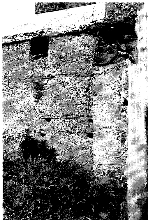
Figura 6 Soluciones constructivas: losas de piedras entre tapialadas
