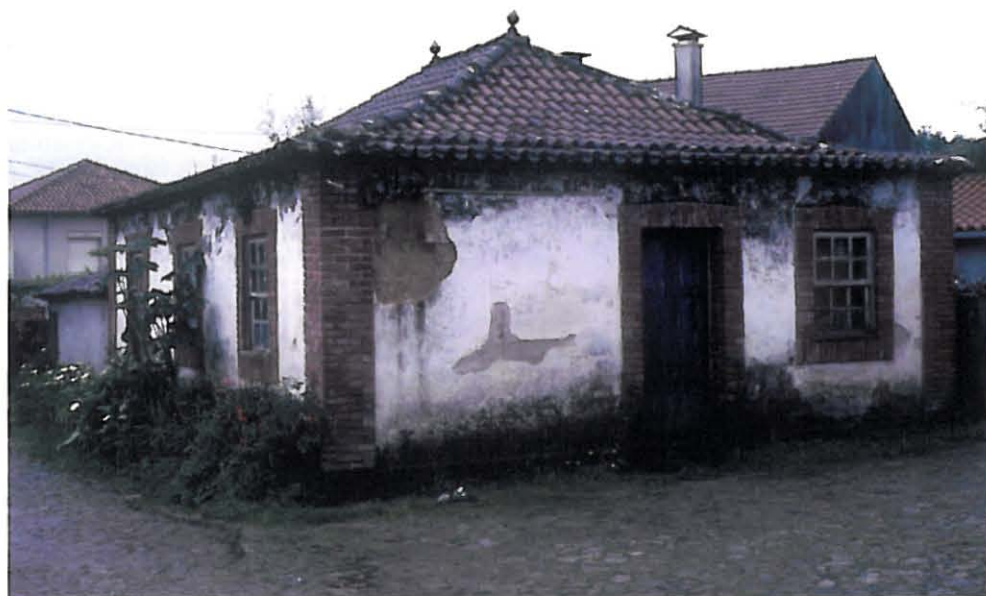
Habitação em taipa na freguesia de Lanheses, concelho de Viana do Castelo (denominada tapia pelos habitantes locais) Fotografia do autor
