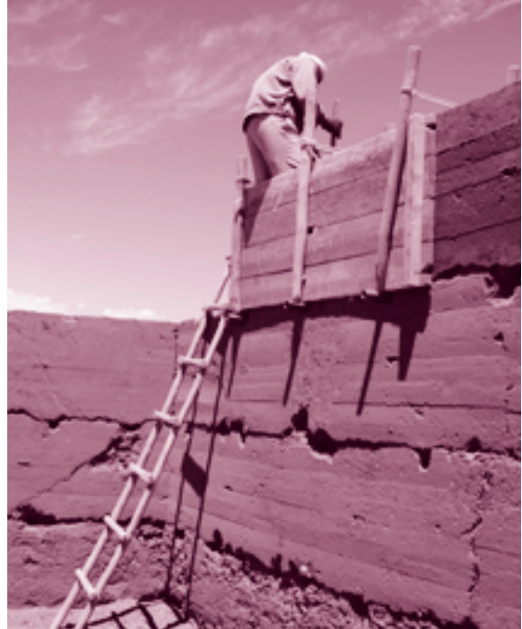
Realização actual de taipa, 2km a norte de Aït Bem Haddou, em Marrocos
