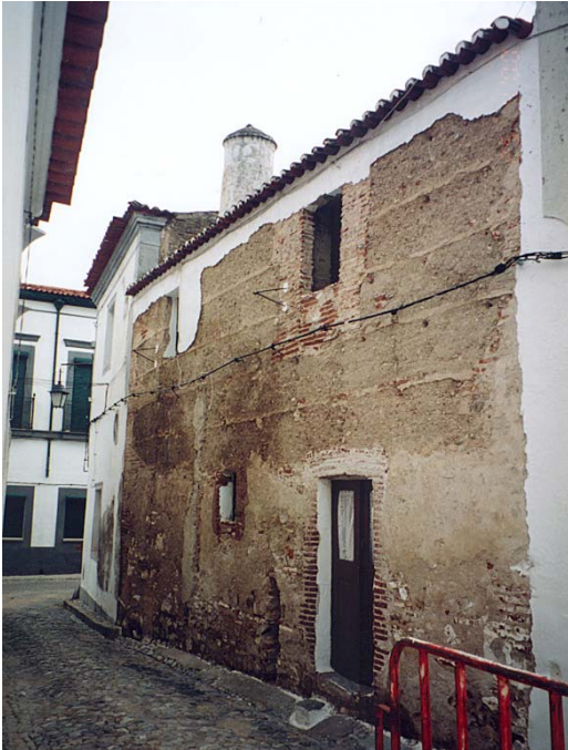
Fig.7 – Edifício de dois pisos, em taipa. Serpa . Concelho de Serpa .
