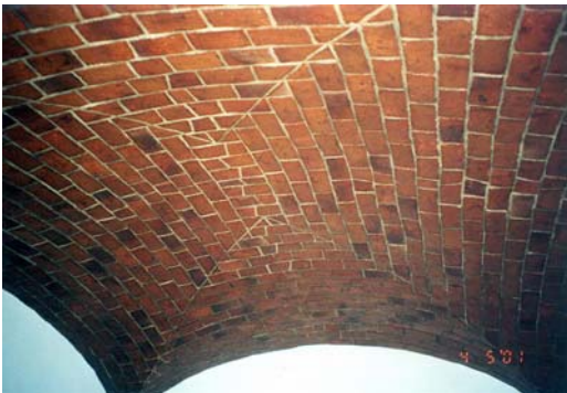
Fig.13 – Abóbada tradicional alentejana na casa 4 das Casas dos Romeiros, no Lugar do Senhor dos Mártires, em Alcácer do Sal.
