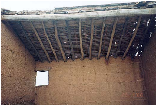
Fig.19 – Caniço apoiado no varedo, que descansa no pau de fileira e encastra na parede. Monte das Fontainhas , em Vale dos Mortos . Concelho de Serpa .
