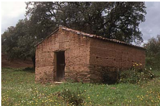
Fig.18 – Casa com paredes em taipa, embasamento em alvenaria de xisto e cobertura de duas águas em telha de canal ou maia-cana. Verga da porta em madeira. Casa do Maioral do Monte da Boa Vista . Concelho de Ourique .
