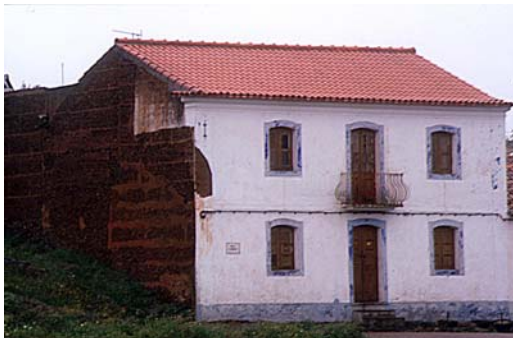
Fig.10 – Embasamento e cercadura dos vãos pintados de azul, em edifício de taipa, em Vale dos Mortos . Concelho de Serpa.
