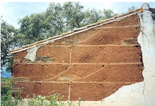
Fig.15 – Taipa com pedra no topo das juntas verticais na Casa do gado do Monte Pelicão, em Saraiva, Concelho de Ourique.
