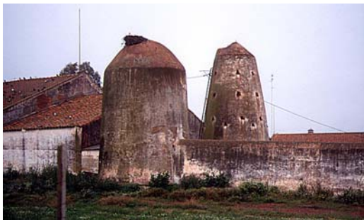
Fig.3 – Silos construídos em taipa na Herdade de Vale dos Mortos. Concelho de Serpa.
