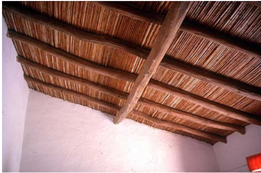
Fig.16 – Caniço apoiado no varedo, que não flexa devido à madre ou terça existente a meio do vão. Habitação no Telheiro . Concelho de Reguengos de Monsaraz .
